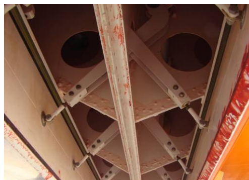
Internal baffles and door actuators
